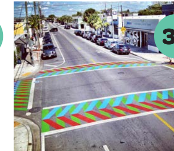
Crosswalks Paso de Peatones
